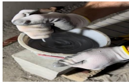
c) Mixing Resin Primer Coat
